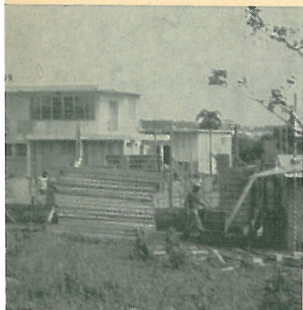
n pågående tillbyggnaden.
