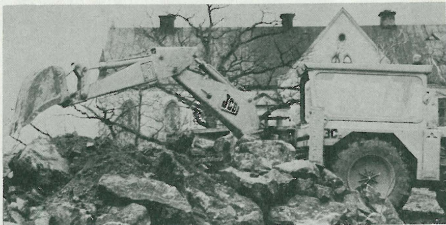
Arbetet med grunden pågår mitt under gröna vintern...
