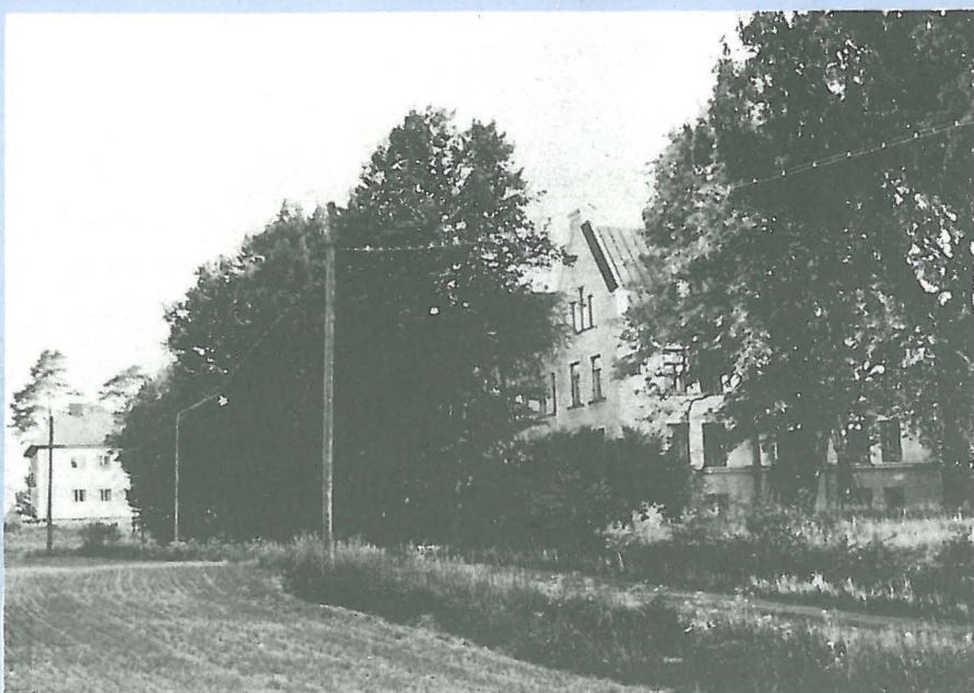
Gärdshyttans gård består av flera hus. Närmast syns huvudbyggnaden med matsalar, bostadsutrymmen och arbetslokaler. I bakgrunden syns huset som rymmer Pilgrimshem.
