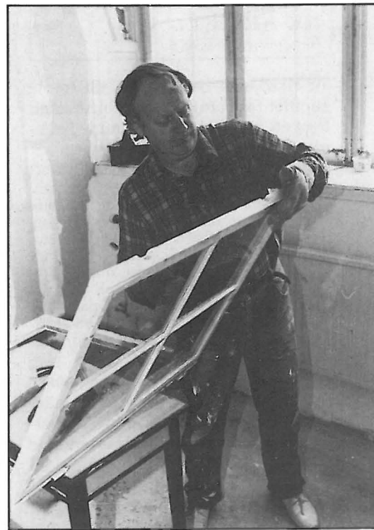
Folke Jakobsson leder ombyggnadsprojektet i huset.
