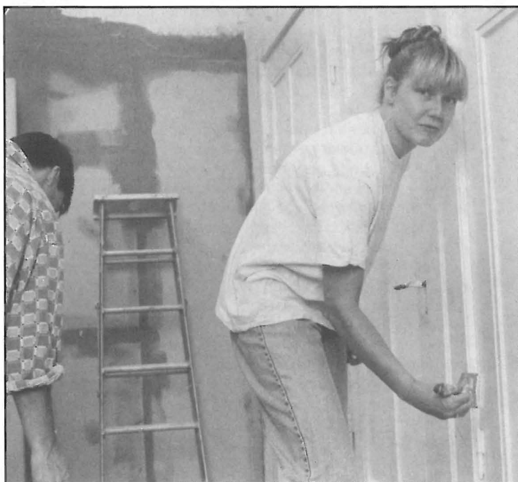
Skolbarnens föräldrar hjälpte själva till med att färdigställa de nybyggda klassrummen. Här är det Vivianne som målar dörrar och lister. Till vänster skymtar maken Jonas.
