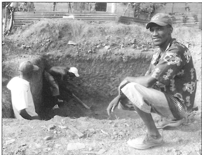
Marceló vid gropen som grävs för att rymma den 27 000 liter stora vattencisternen.
