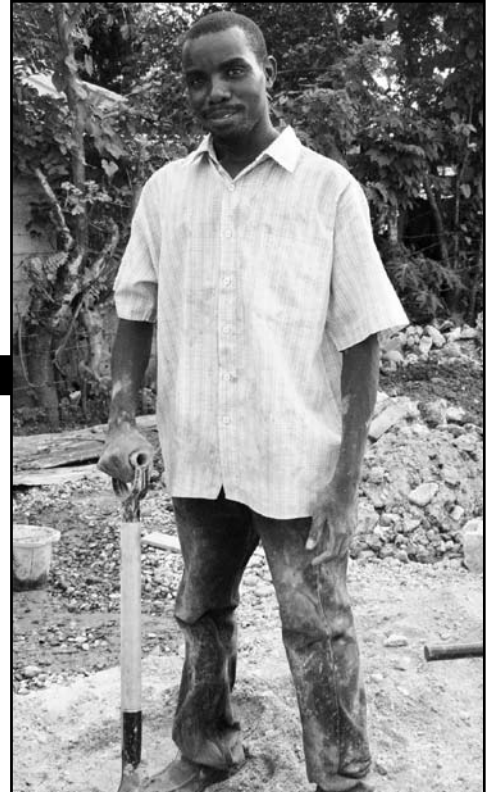
Michelot deltar ivrigt i byggnadsarbetet i Palavé. Här tar han en kort paus från att blanda cement för att vara med på fotot.
