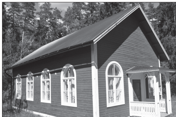
Sveriges alla bönehus och kapell vittnar om väckelsetider som flytt, men hur förvaltades välsignelsen som följde. De flesta kapellen står sedan länge tomma och vi lever i ett land under andlig missär. På bilden syns missionshuset i Spannarboda.
