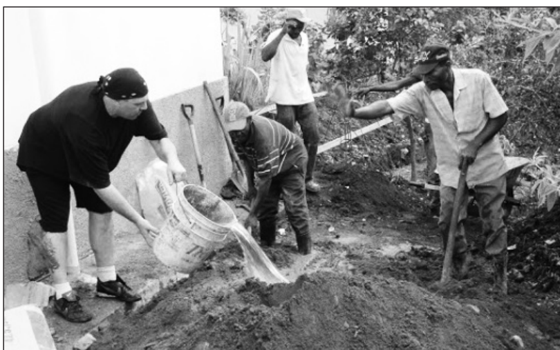
Simon var med och byggde hus i Palavé. Här skall cementen blandas vilket görs för hand direkt på marken.
