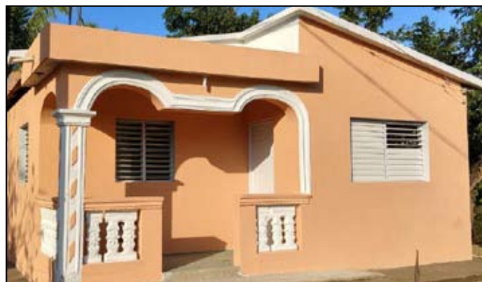
Det nya huset färdigmålat
